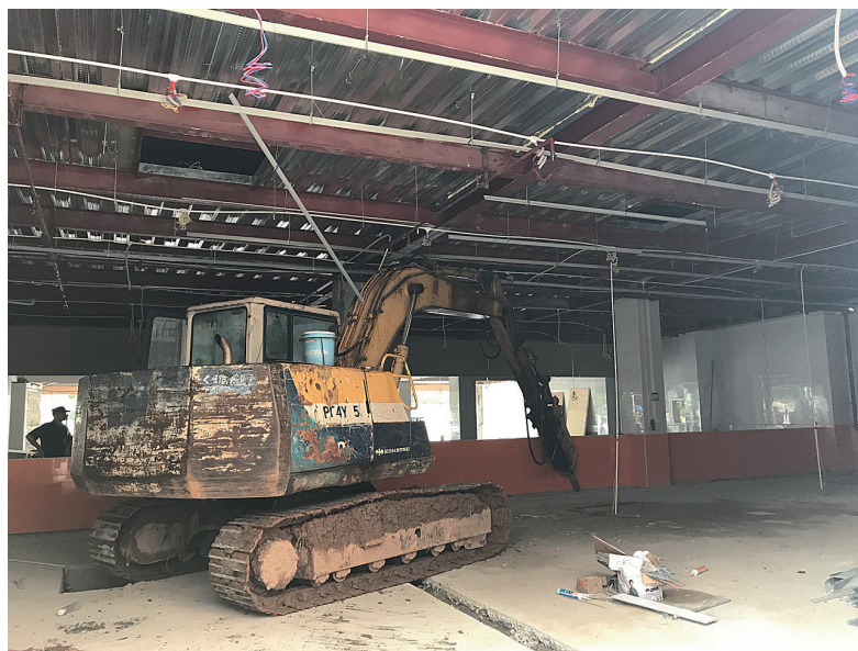
拆除现场。深圳侨报记者 任翠翠 摄
