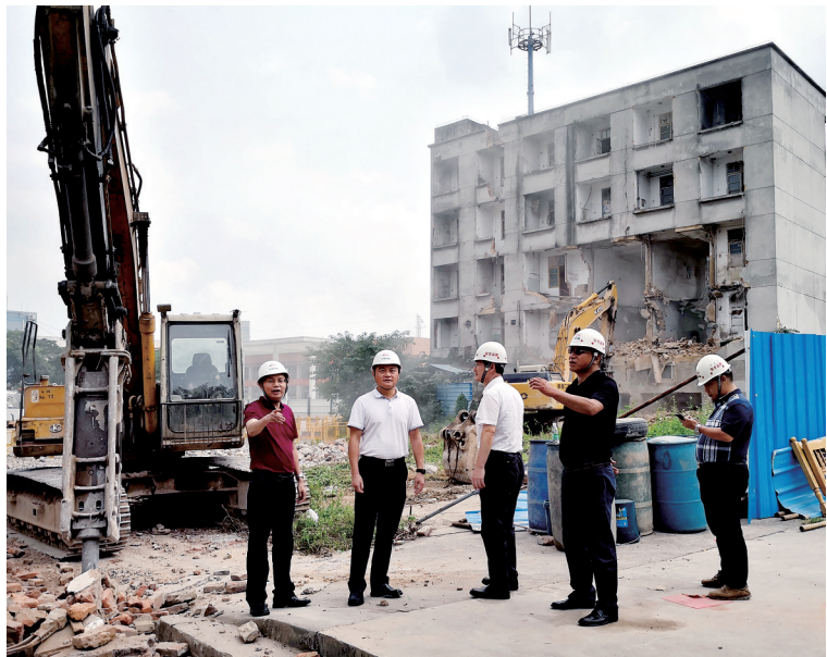
9月5日,平湖街道相关负责人到广铁职工宿舍楼拆除现场督促并检查安全拆除工作。
