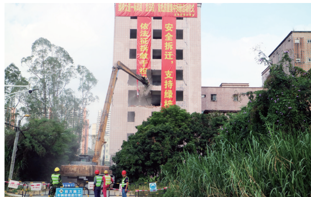
绿梓大道一标B段(龙田段)已征房屋拆除中。
