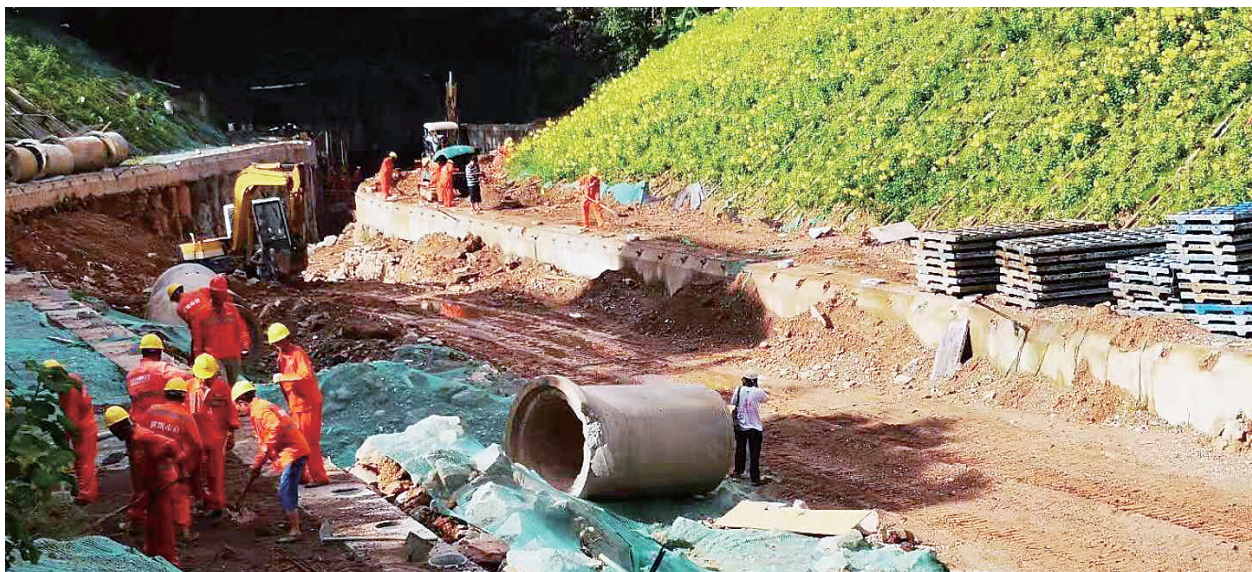
施工人员正在水径水沿河埋设截污管道。受访者徐涛供图
