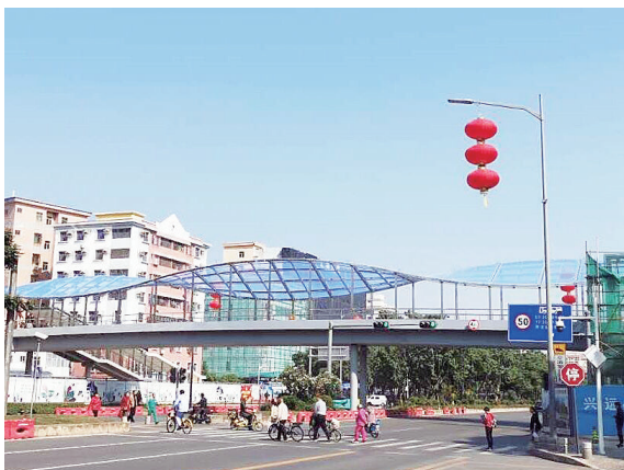
建新社区人行天桥近期验收合格后投入使用。
