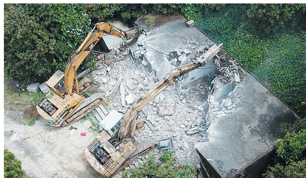
拆除违法建筑。
