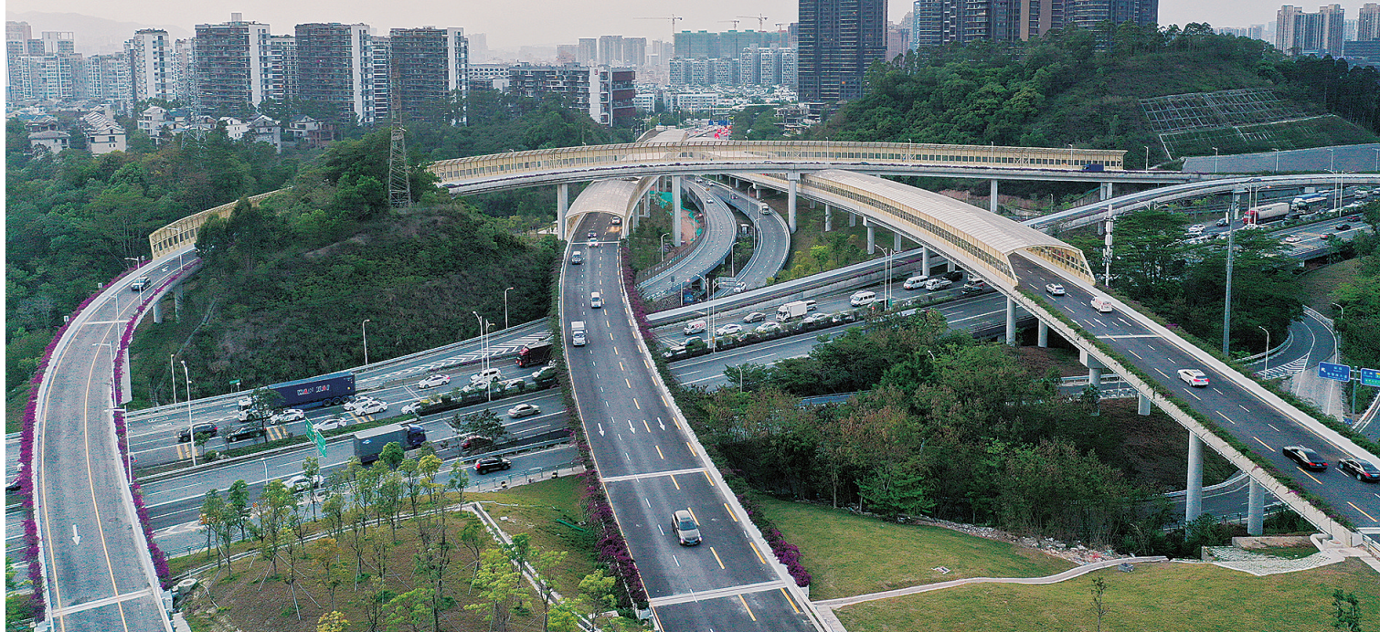
坂银通道的通车,为龙岗交通出行再添一份新便利。龙岗融媒通讯员 李逸郎 摄
