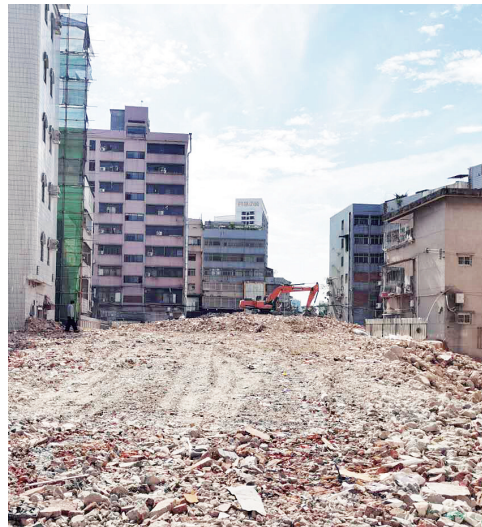
地铁16号线龙双区间征拆现场。
