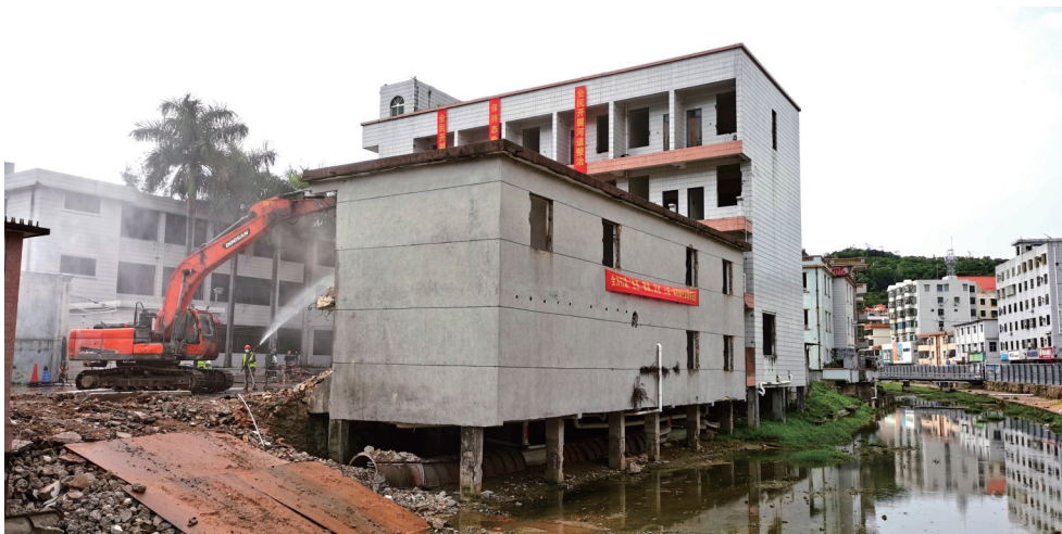
拆除现场。深圳侨报记者 李苑 摄
