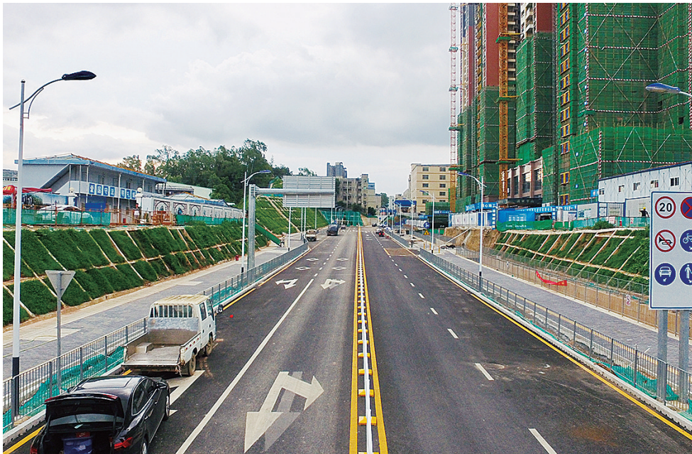
五清路市政工程顺利完工通车。龙岗融媒记者 刘芳菲 摄
