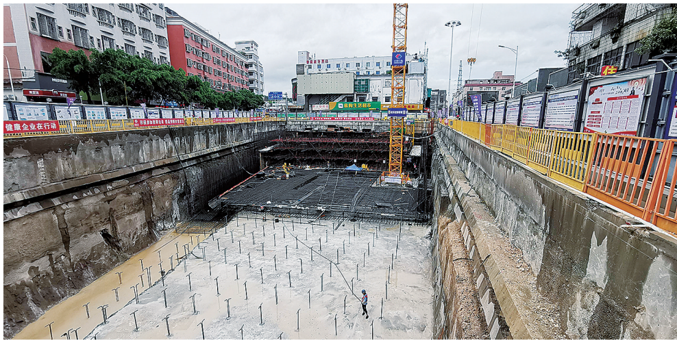
抗浮锚杆施工。龙岗融媒通讯员 王欢 摄
