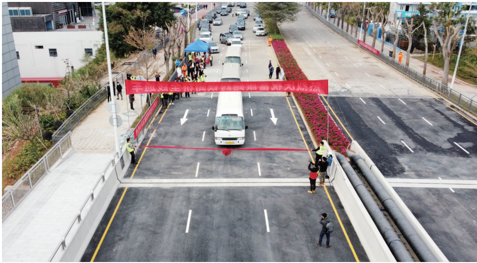
富康路跨广深铁路桥正式通车。龙岗融媒记者 刘芳菲 摄
