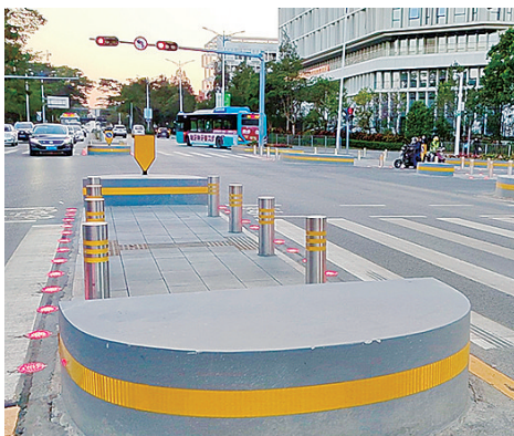
整治提升路口过街设施安全性。
