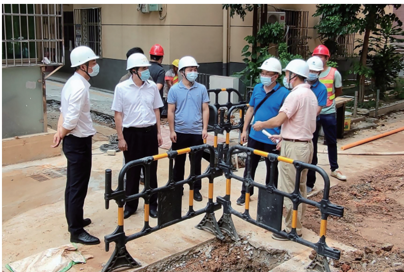
工作人员检查督导城中村管道天然气改造工作。
