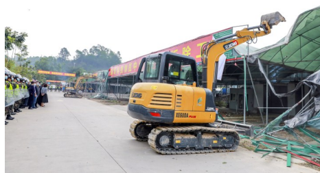
深圳科技博览中心项目首期拆除工程现场。
