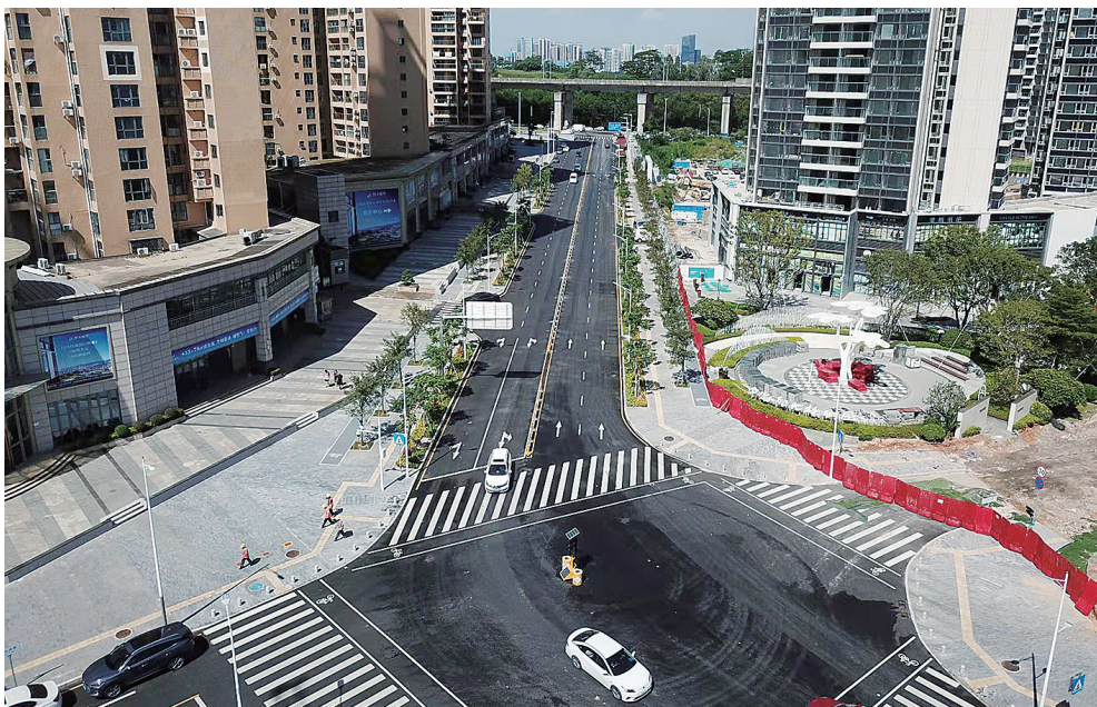
高科西路正式通车。龙岗融媒通讯员 沈岳钊 摄
