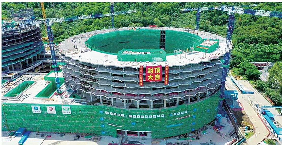
大鹏新区人民医院项目 II 标段主体结构全面封顶。大鹏新区供图
