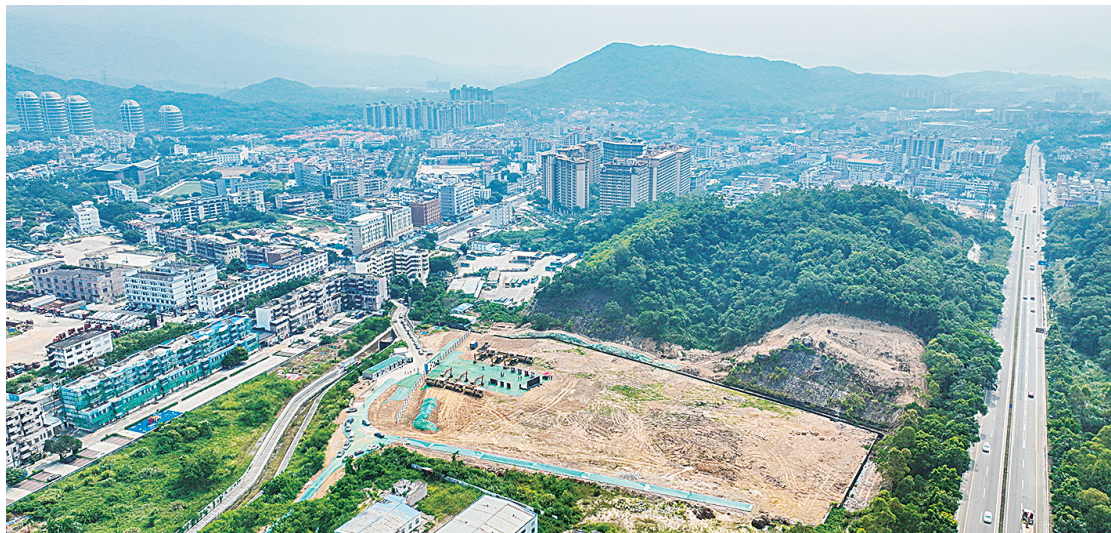
王母社区统建楼项目动工。深圳侨报通讯员 李若石 摄
