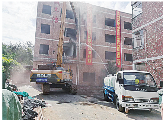
深惠城际大鹏支线项目征拆现场。
