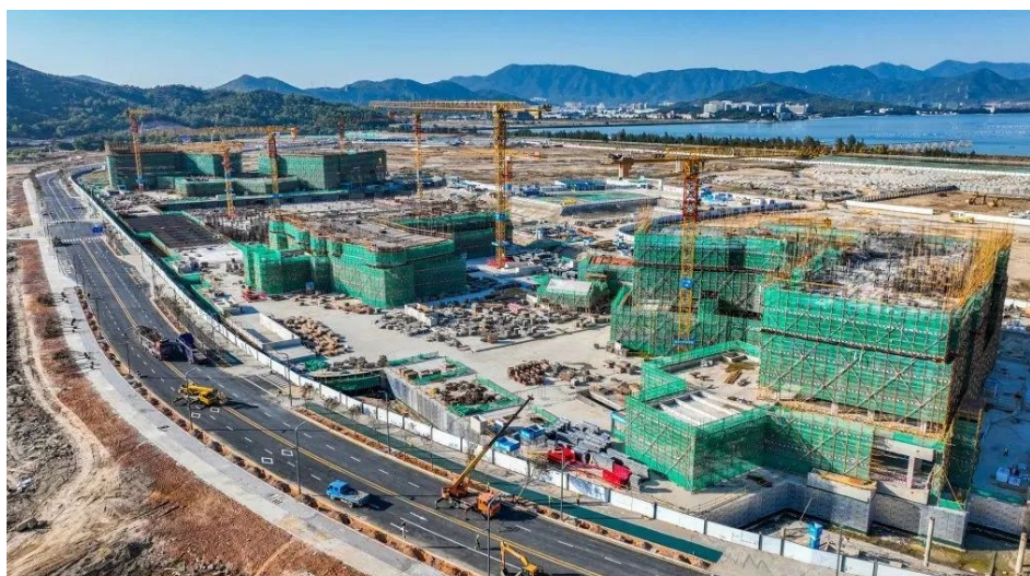
今年2月乐园建设现场。大鹏新区供图
