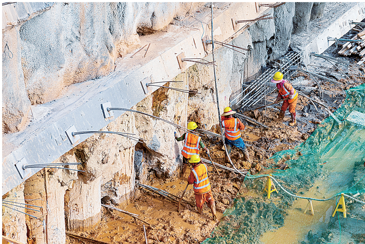
工地上,工人们以极大的工作热情确保项目如期推进。龙岗融媒记者 李凯 摄
