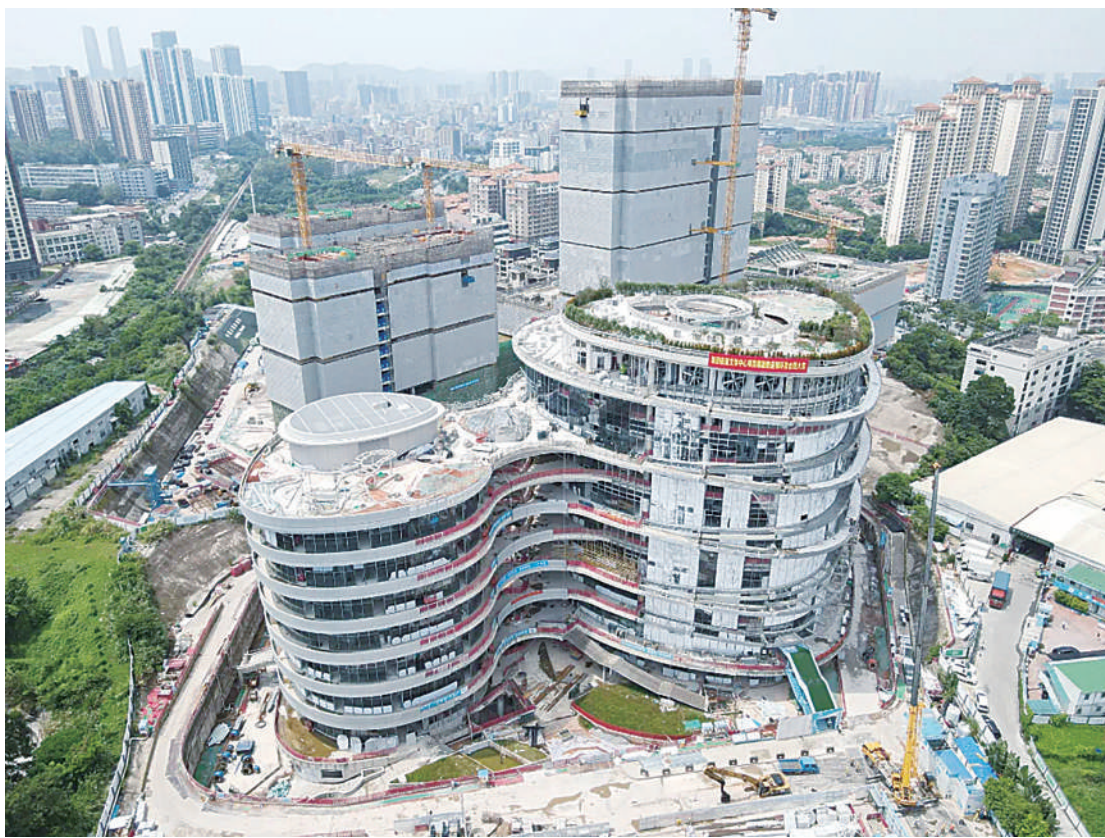
建设中的坂田文体中心。图片来源:坂里田事公众号
