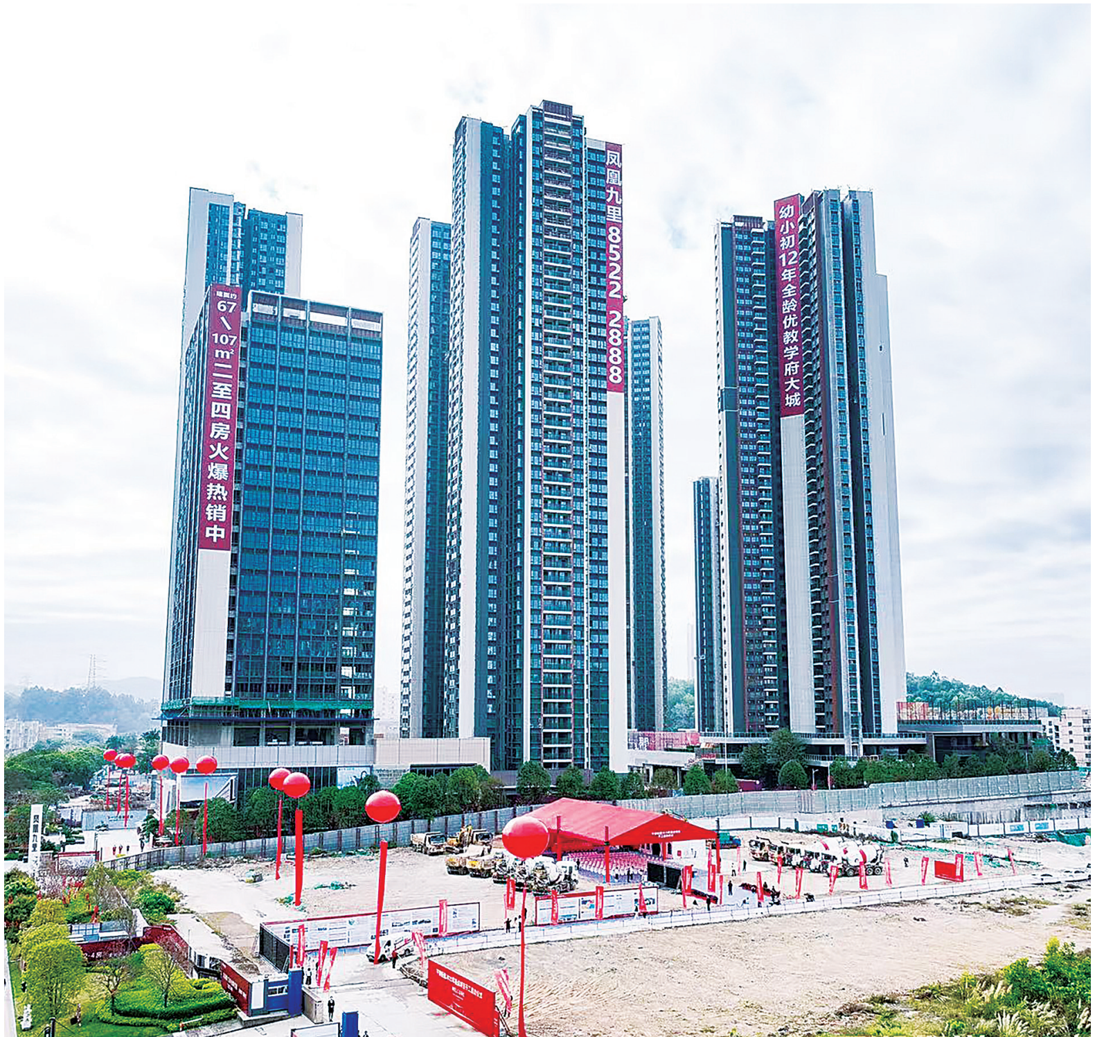
昨日,深圳市龙岗区平湖街道2025年重点项目开工启动仪式在凤凰九里隆重举行,此次集中开工的21个重点项目总投资达134亿元,涉及基础设施建设、城市更新、产业发展、文化旅游等多个领域。图为启动仪式现场。平湖街道供图
